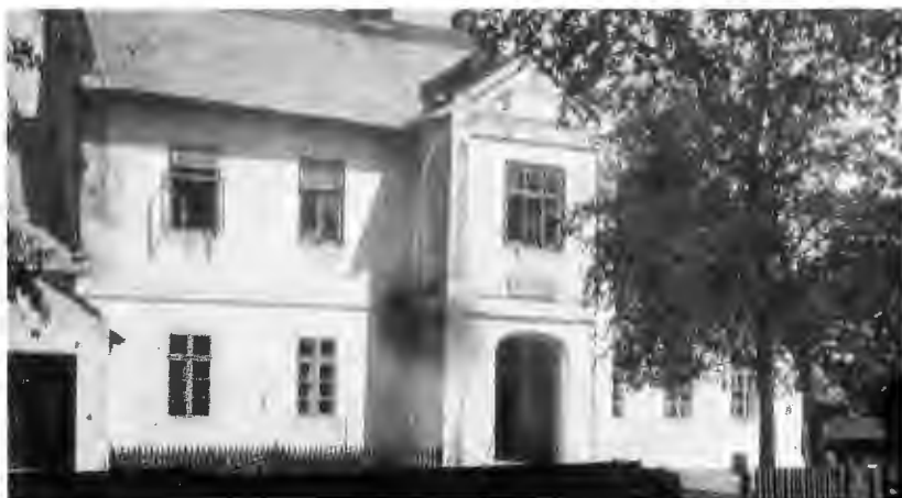
1936 - Budynek dawnej szkoły.
